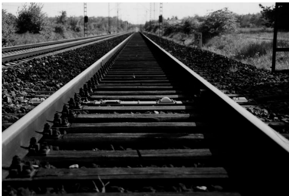
Slika 13: Vgradnja kontrolnega praga za podvozje (KPP) v tir
